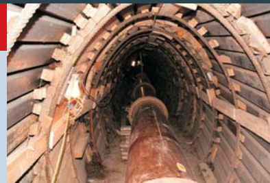
Bild 3: Neuverlegung von Steinzeugrohren
