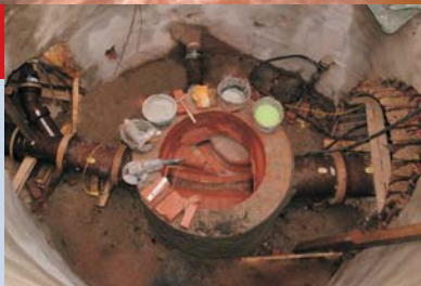
Bild 4: Schachtbauwerk in der Stollengrube
