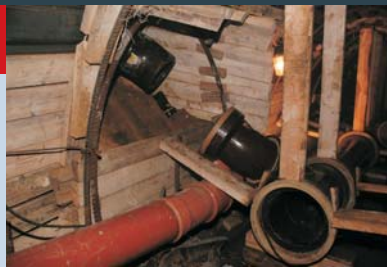
Bild 2: Querstollen für Seitenanschlüsse
