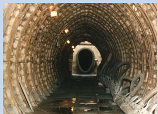
Bild 6: Grundwasserhaltung im Stollen
